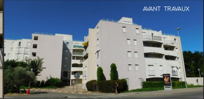
Programme de rénovation énergétique de 5 bâtiments d'habitation, avec mise en place d'une ITE en façades, remplacement des fenêtres, radiateurs et VMC des appartements.
